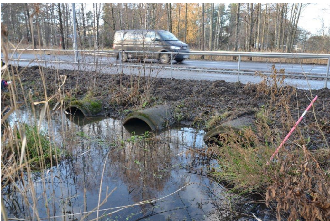
Figur 5:12. De tre utloppsroren från våtmarken under Ältavägen. Flödesriktningen är in i bilden som är tagen den 8 december 2017.
